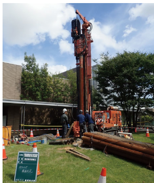
豊田自動織機大府工場での地中熱交換機挿入のためのボーリングの様子。 約100mの位置まで掘削
