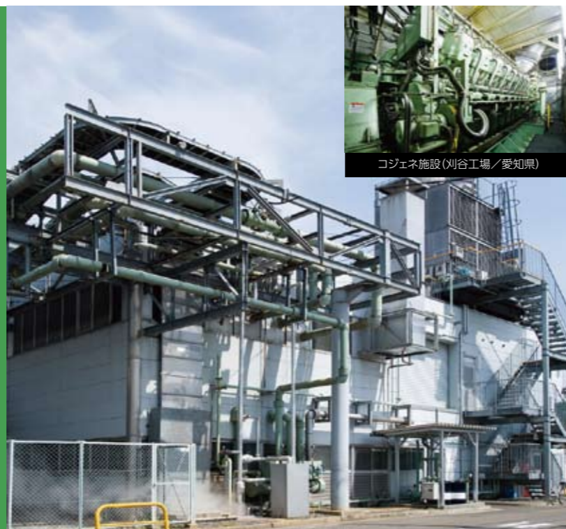
コジェネ施設の外観(刈谷工場/愛知県)
