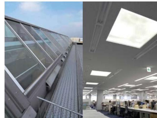
光ダクト+調光システム(高浜工場/愛知県)
