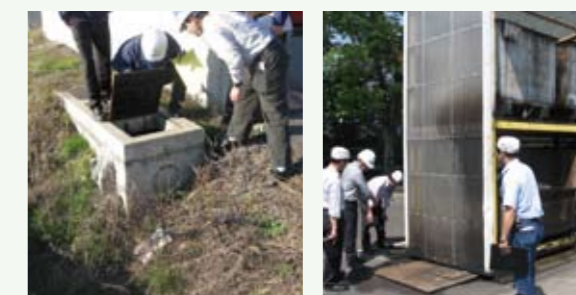
排水系統の調査
