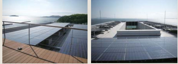
太陽光パネル
