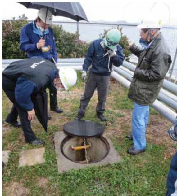
現地・現物での排水設備の点検(国内連結子会社)
