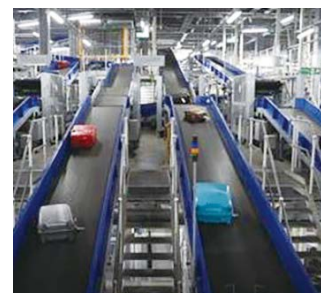
空港手荷物搬送システム
