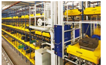
手荷物搬送システム(ヒースロー空港)
