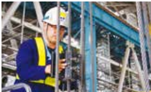
ワイヤロープ内部破断調査
