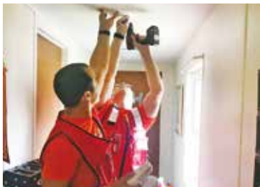
煙探知機の点検
