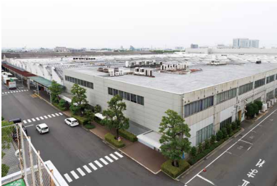
コンプレッサーのマザー工場(刈谷工場)
