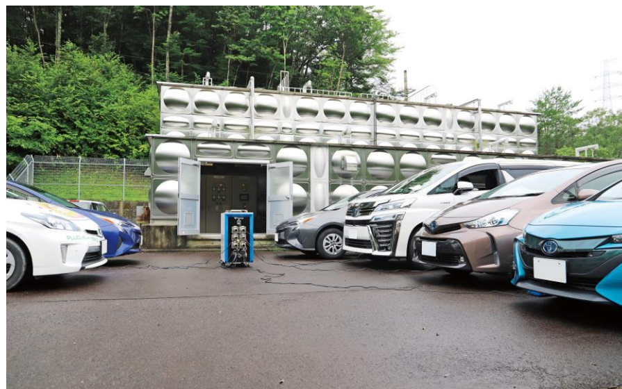
配水ポンプ稼動の実証実験
