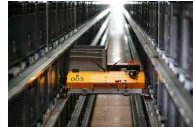
シャトルタイプ自動倉庫
