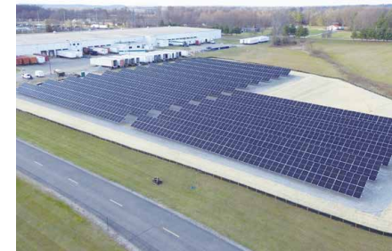
設置した太陽光パネル
