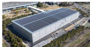
新設した物流棟
