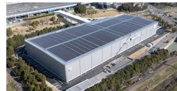
新設した物流棟
