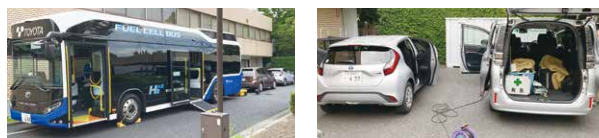
電動車を非常用電源の一部として活用する訓練
